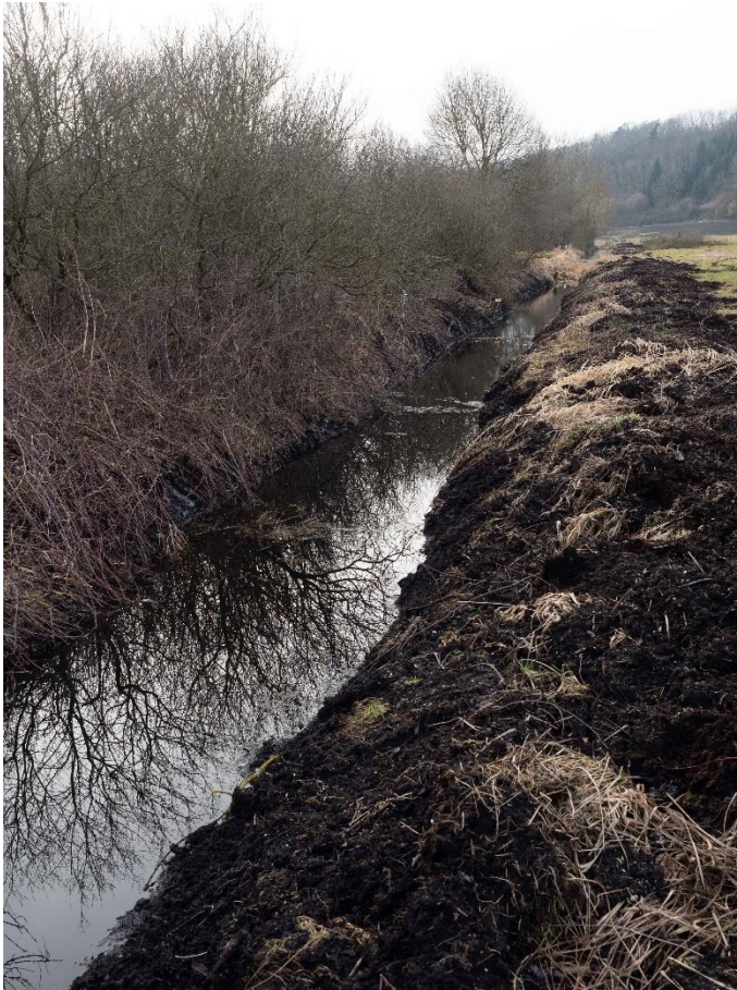
Foto 3: Grabenräumung im Winter 2019/20 mit Vertiefung der Gewässersohle
